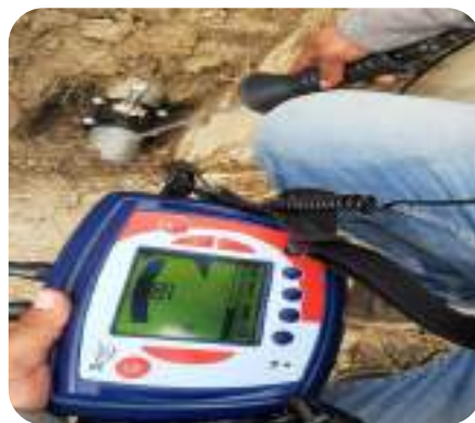
Figura 36. Sesión de escucha con geófono en tubería principal
