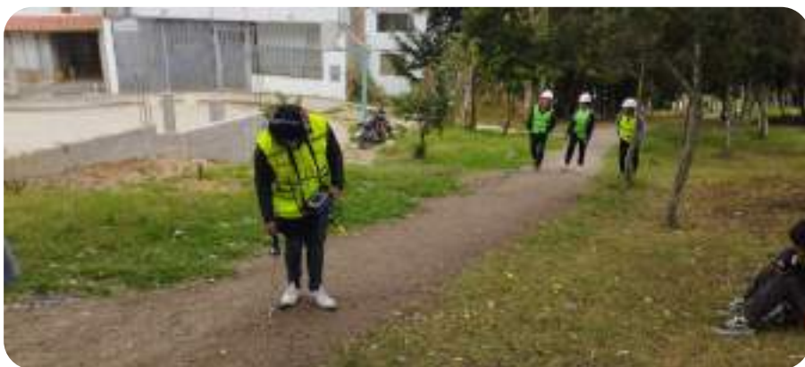
Figura 37. Operador realizando sesión de escucha con geófono sobre pavimento
