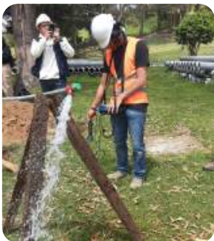
Figura 48. Simulación de fuga de agua
