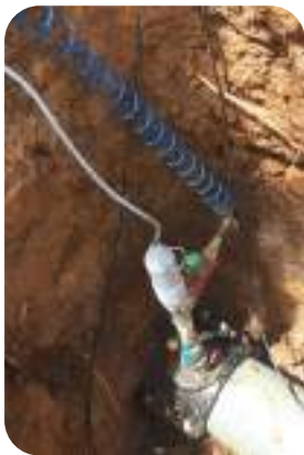
Figura 44. Pozo 1 excavado para la instalación del transmisor 1 del correlador Nota. Fotografía tomada en campo, Estación de Bombeo Curitroje.
