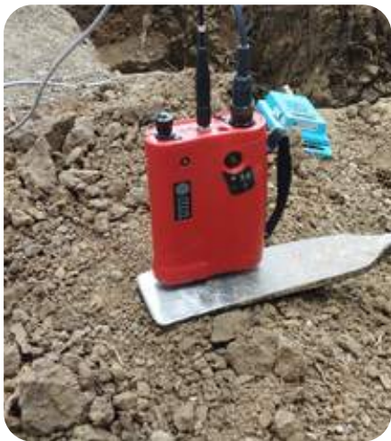
Figura 31. Transmisor 1 del correlador instalado en la tubería Nota. Fotografía obtenida en campo, Estación de Bombeo Curitroje, 2024.
