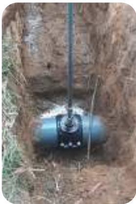
Figura 45. Pozo 2 excavado para la instalación de llave de paso con fines de simulación de fuga Nota. Fotografía tomada en campo, Estación de Bombeo Curitroje.
