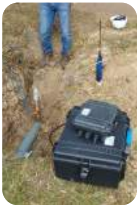
Figura 46. Pozo 3 excavado para la instalación del transmisor 2 del correlador Nota. Fotografía tomada en campo, Estación de Bombeo Curitroje.
