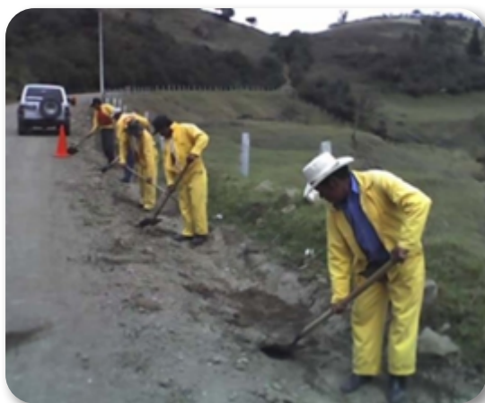
Figura 1. Limpieza de cunetas. Microempresa Manos Unidas, vía Cutchil-Ludo, 24 Km longitud, Sígig, Azuay
